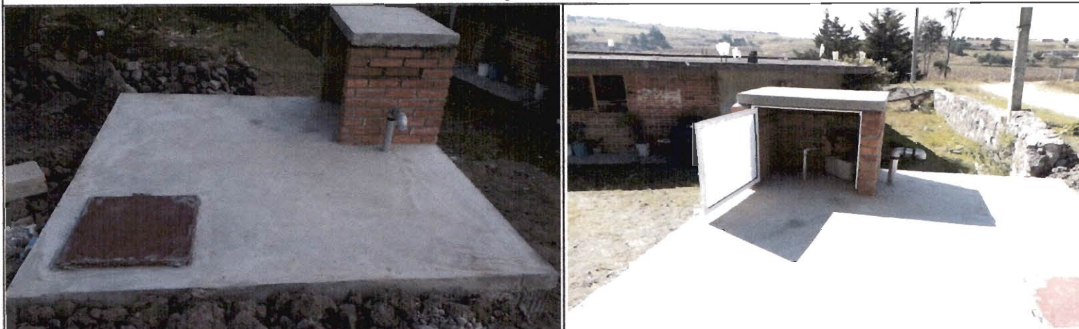
Fotografías de la Obra
