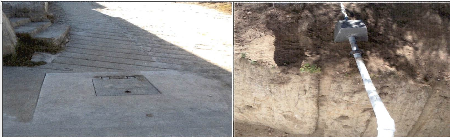
Fotografías de la Obra
